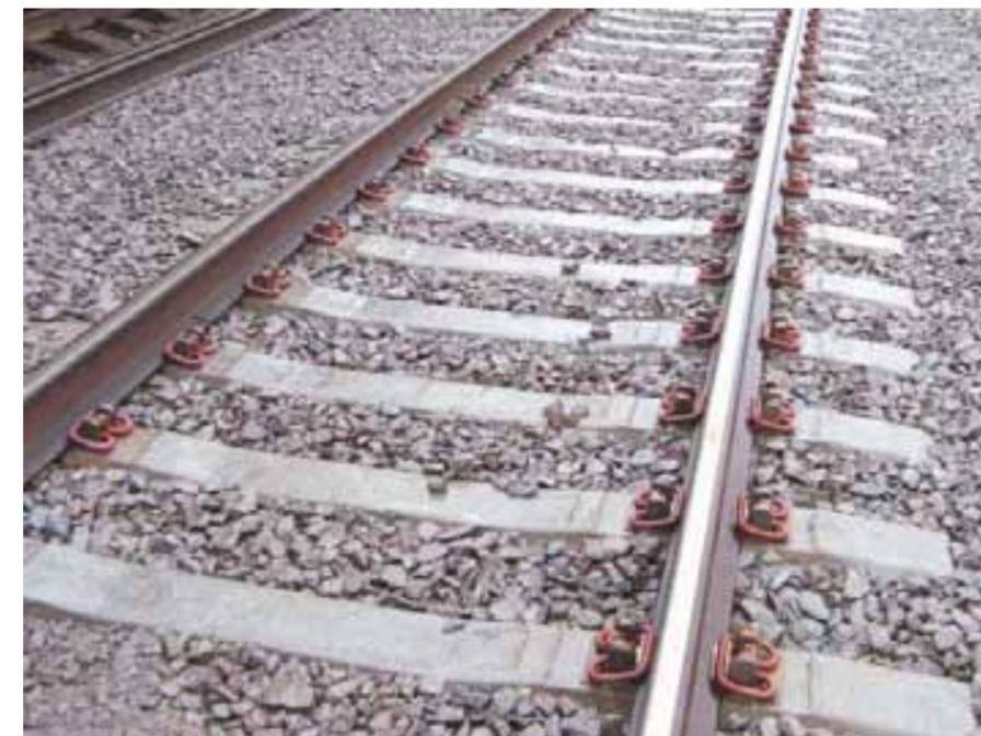
**Рис. 15.** Рельсошпальная решетка со шпалами Ш-А05 и усовершенствованными деталями
