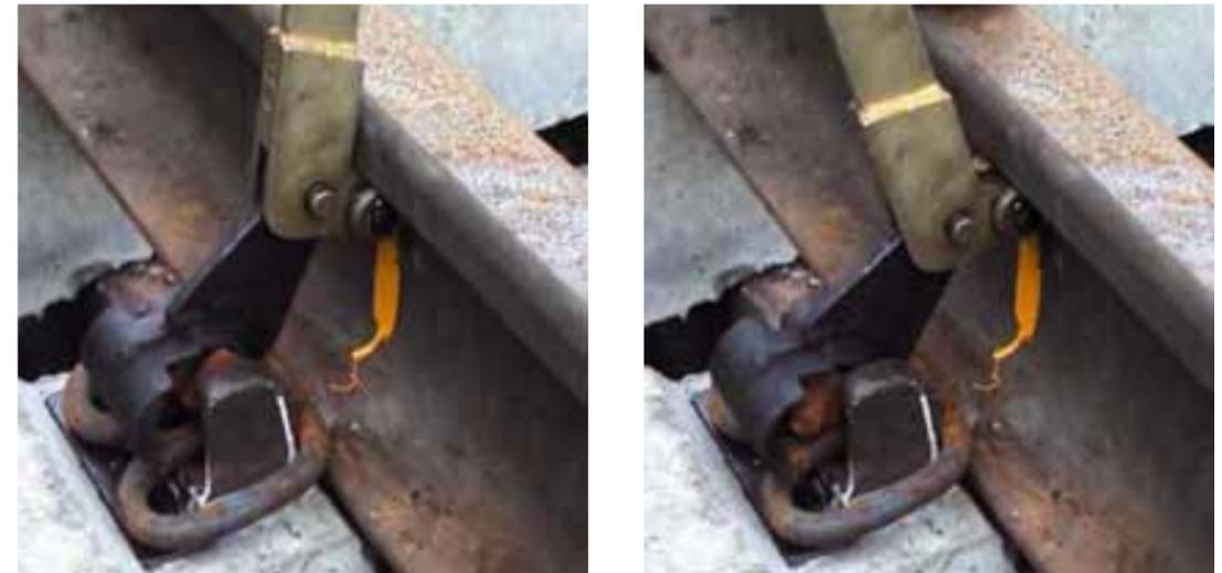
Рис. 18. Устройство для демонтажа монорегуляторов
